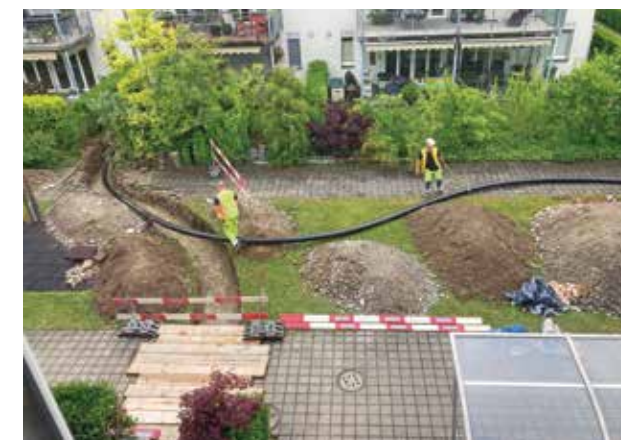
Verlegung der Warmwasserleitungen in den Boden – wegen der darunterliegenden Einstellhalle nicht tiefer machbar. (Bilder David Kamber)
