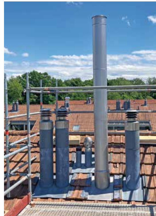
Nach aussen sichtbar ist einzig ein 2 Meter über die Dachfläche ragender Kamin.
