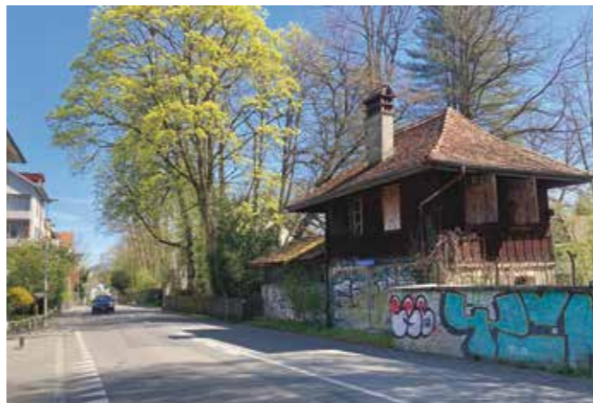
Das an die Morillonstrasse angrenzende ehemalige Waschhaus wird ab Herbst in frischem Glanz erstrahlen.
